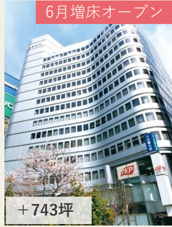
東京駅 カンファレンスセンター
