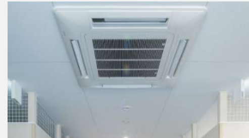
荷物に配慮した環境設備
