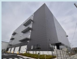
(左) アドベル 明石町ビル (右) 神中興業 神中本藤沢物流センター
