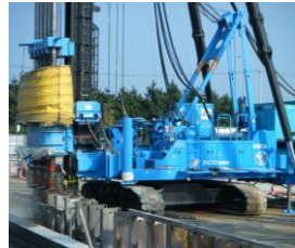
ソイルセメント柱列式連続壁工法
