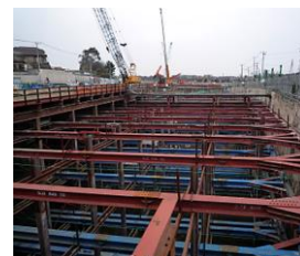
各種仮設解体工事
