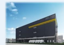
冷凍冷蔵物流施設 (横浜市都筑区)
