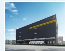
冷凍冷蔵物流施設 (横浜市都筑区)
