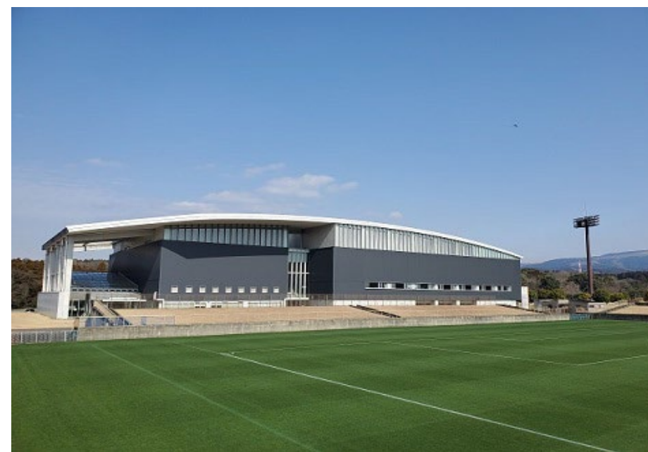
● 大津町総合体育館
