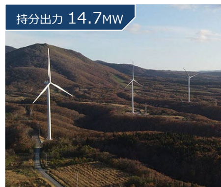
北海道 江差風力発電所
