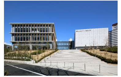
(仮称) 東京情報デザイン専門職大学新築工事 (東京都)
