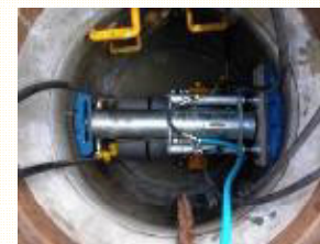
マンホール耐震化工事
