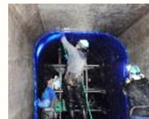
管渠更生工事
