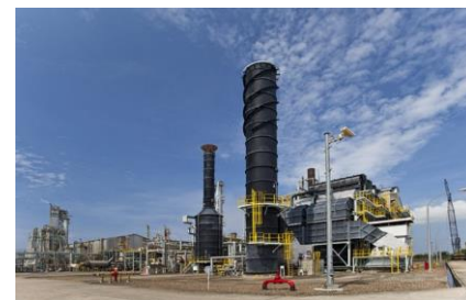
PIM社既存プラント全景
