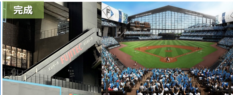
エスコンフィールドHOKKAIDO (日本・北海道) エレベータ13台・エスカレータ14台 計27台
