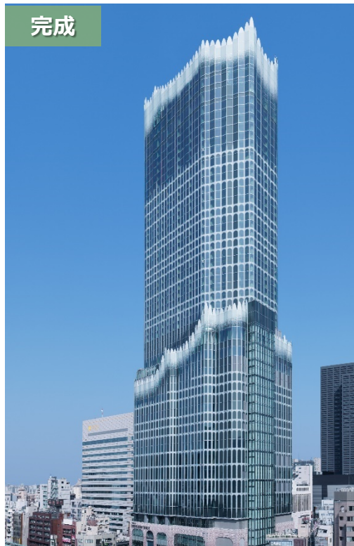
東急歌舞伎町タワー (日本・東京) エレベータ7台
