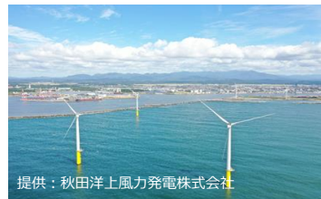
秋田港洋上風力発電所
