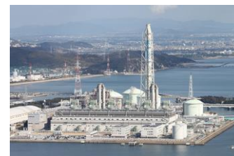
姫路第二発電所（天然ガス）
