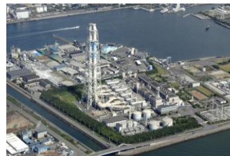
姫路第一発電所（天然ガス）
