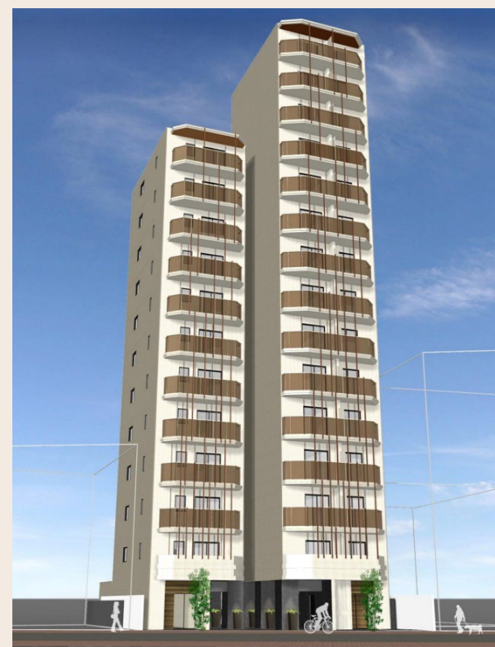
アルテシモ渋谷本町A棟B棟 2024年8月竣工予定
