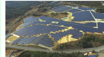
LS三原発電所(発電容量:11MW)
