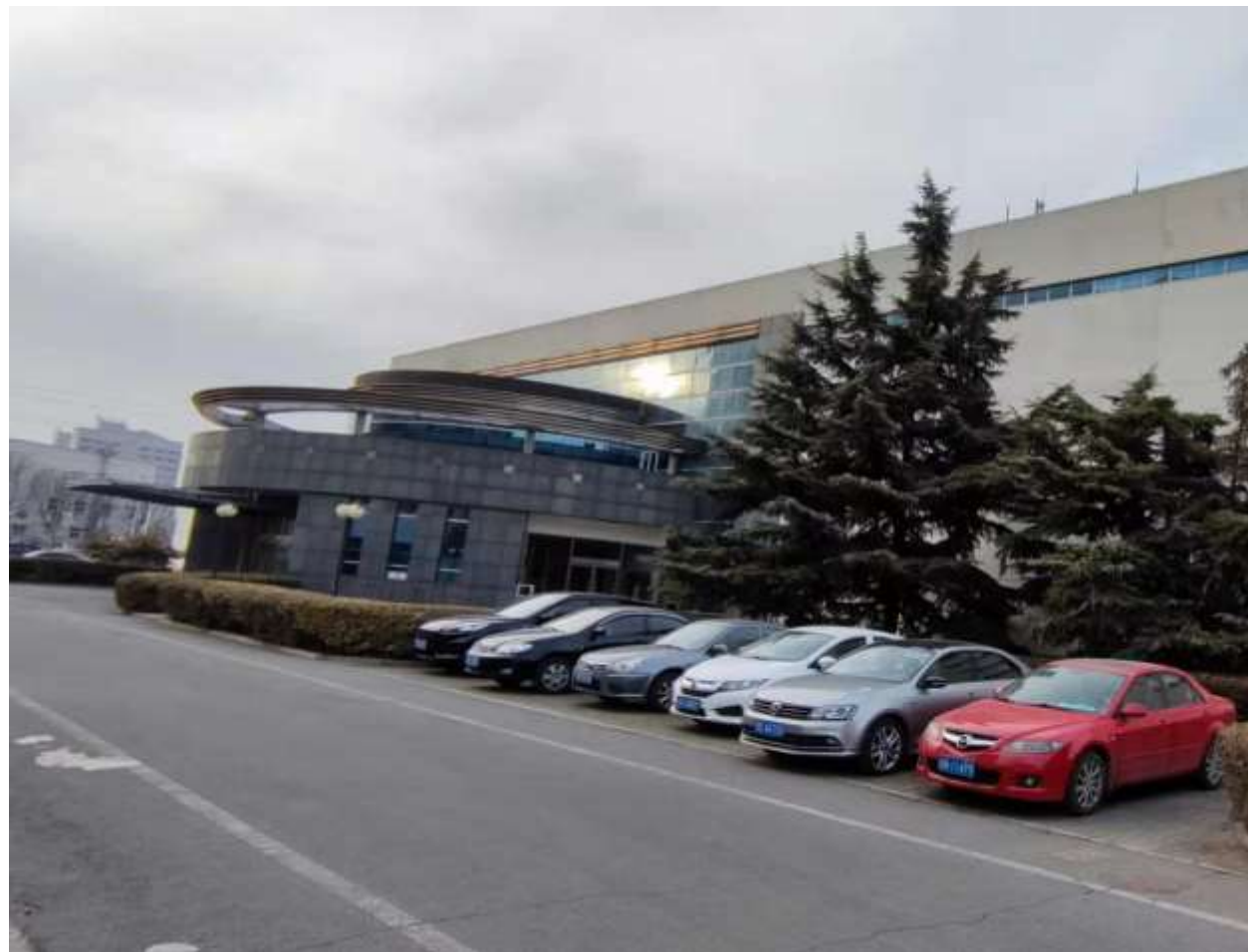
※写真は、中国北京市にあるSGRS研究開発センター
