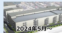
鹿児島国分工場 新棟
