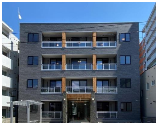
SE構法木造ビル
