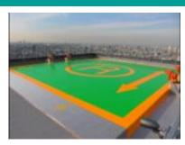
■ 高層ビルの災害時に高い視認性で効果を発揮 する緊急離発着場専用の蛍光塗料
