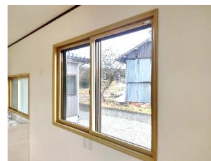
内窓の設置事例
