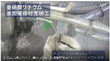
亜硝酸リチウム添加補修剤充填の確認
