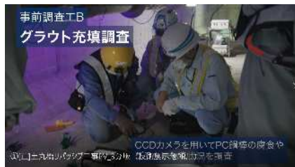
【事前調査】グラウト充填調査
