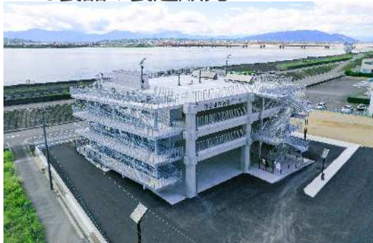
桑名市津波避難施設
