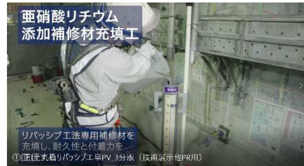
阪和自動車道 土丸橋 PC上部工補修工事 【2022年度竣工】
