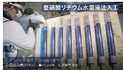
亜硝酸リチウム添加補修剤充填工
