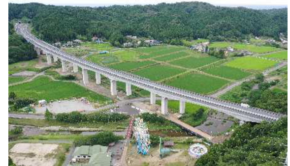
常磐自動車道大久川橋
