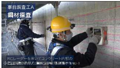
【事前調査】鋼材探査
