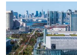
インフラ設備
