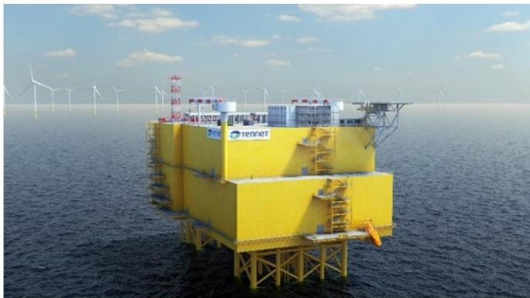
2GWの洋上プラットフォーム(写真提供:テネット)
