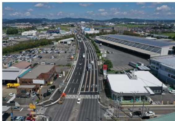
41号名濃バイパス上小口南地区舗装工事 (国土交通省中部地方整備局)
