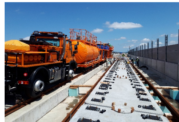
北陸新幹線 福井軌道敷設他工事
