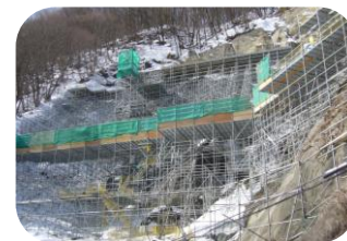
斜面で作業構台に 「YTロックシステム」
