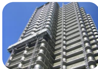
移動昇降式足場 「リフトクライマー」
