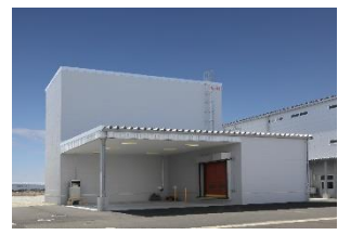
立体自動倉庫 (W-11)
