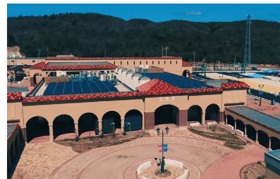
高速道路施設工事
