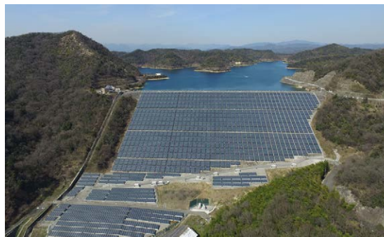
神谷ダム太陽光発電施設
