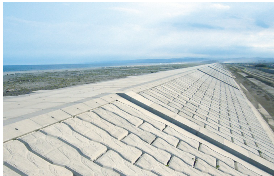
海岸整備工事
