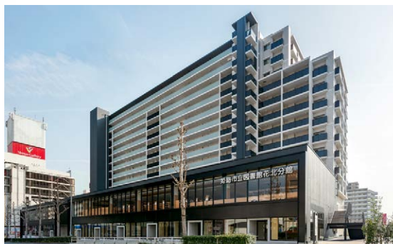
マンション工事
