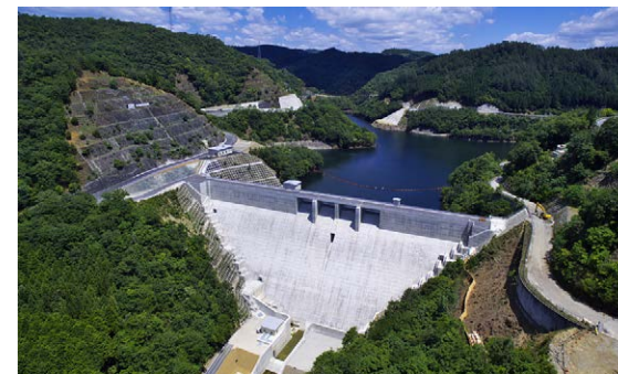
金出地ダム堤体
