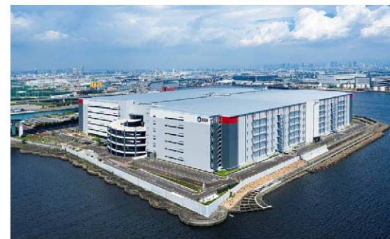
物流施設工事
