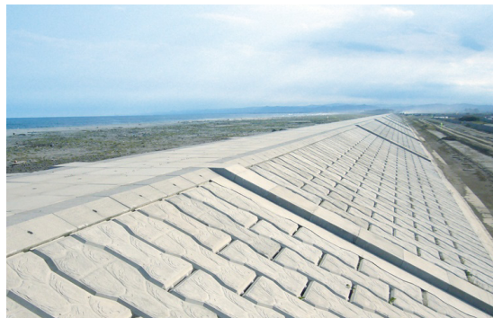
仙台湾南部海岸閉上北釜工区
