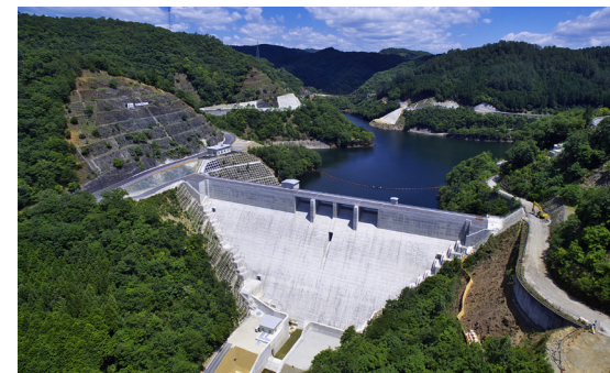
金出地ダム堤体
