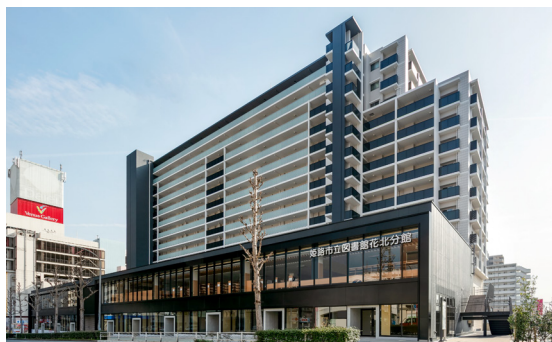
マンション工事
