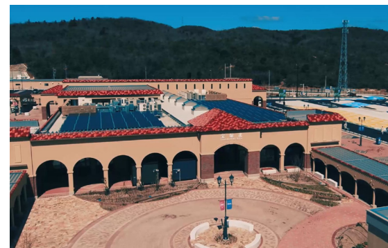
高速道路施設工事
