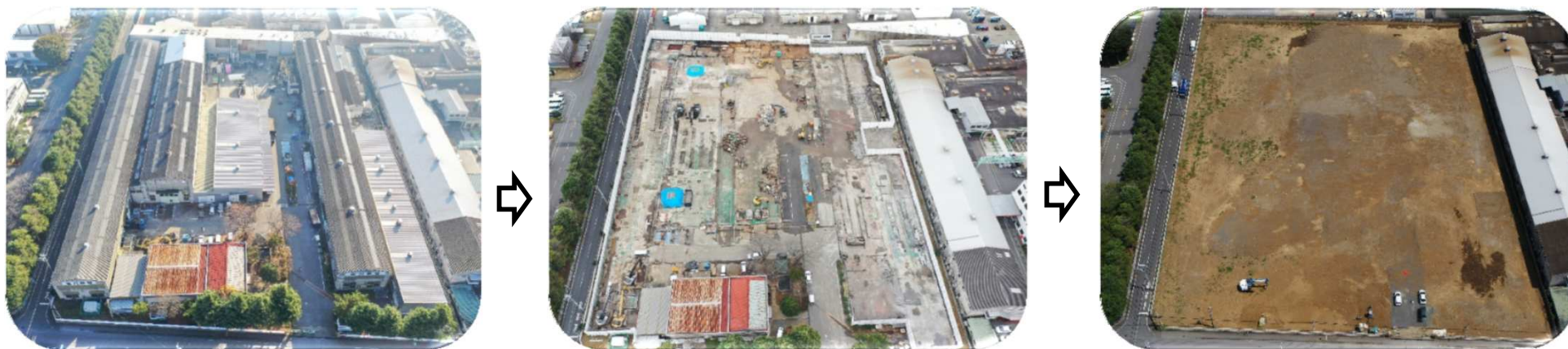
解体と土壤汚染対策を並行して施工した事例
