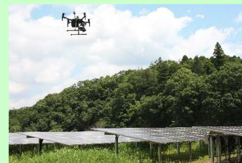
グループ内発電所の点検にも ドローンを利用
