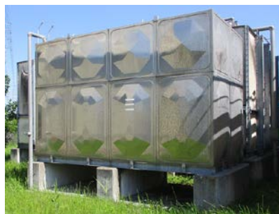
受水槽の高上げ
