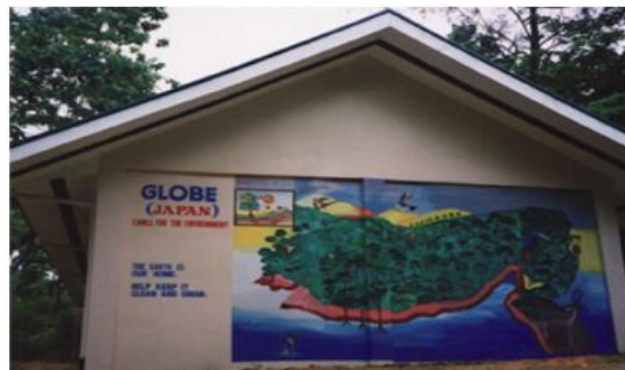
フィリピン・セブにおける「ヒンガトモナン小学校」の修繕と新校舎設立
