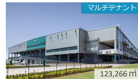
プロロジスパーク古河4 (茨城県古河市) 2023年5月竣工
