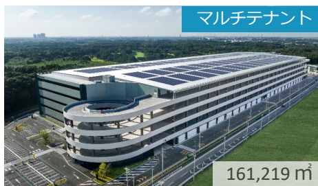
プロロジスパーク八千代1 (千葉県八千代市) 2022年9月竣工
