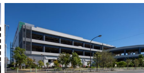
M-16 プロロジスパーク東京新木場
