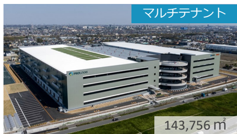
プロロジスパーク草加 (埼玉県草加市) 2022年3月竣工
