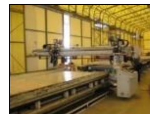
パネルシージングライン (自動釘打ちマシン)
