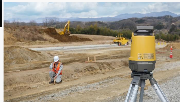
施工現場での使用事例
