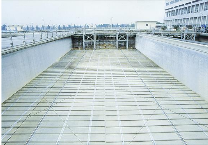
「レシプロ式汚泥掻寄機と高濃度排泥装置の組合せ例」
