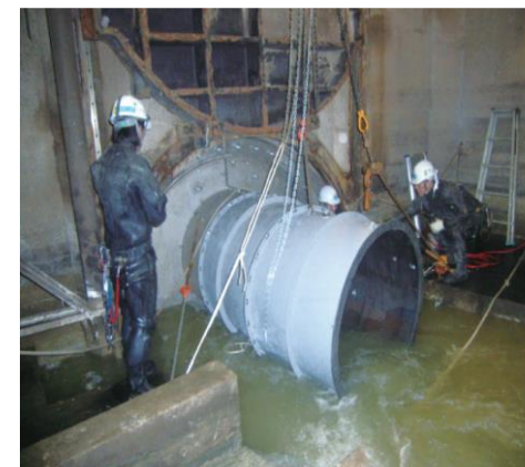
バイパス接続中
