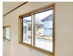
内窓の設置事例
