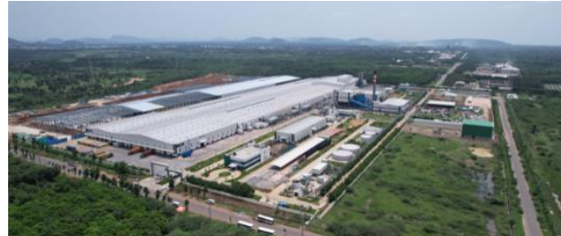
インド・ヴィシャカパトナム工場（左側が建設中建屋）
