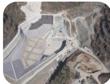
2022年2月 稼働開始 新規管理型最終処分場
