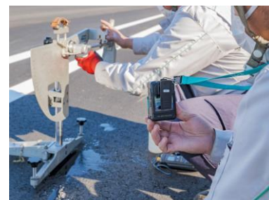
現場で施工業者が 試験の様子を撮影
