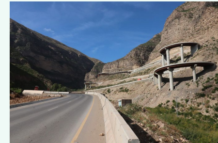
パキスタン国 国道70号線改良工事
