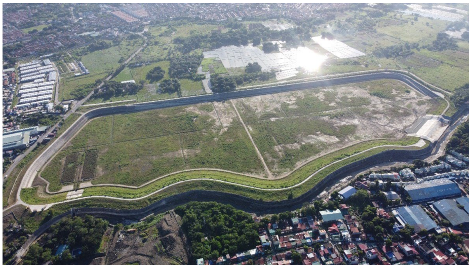
イムス遊水地（フィリピン初の遊水地建設、施工後6か月経過）
