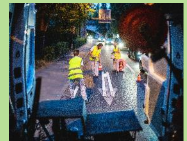
建設・土木業者
