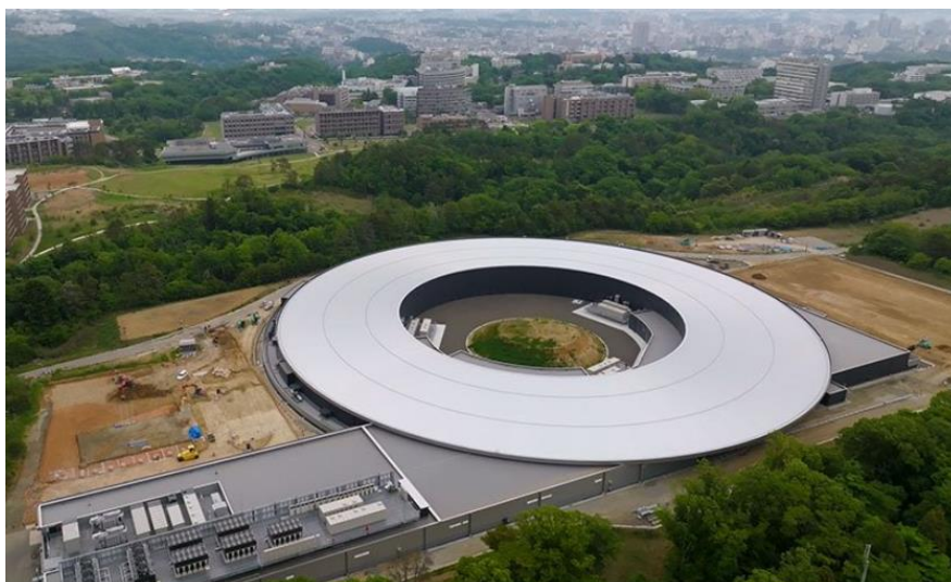
建設中のNanoTerasu（ナノテラス） （2022年6月21日 東北大学 ホームページより）
