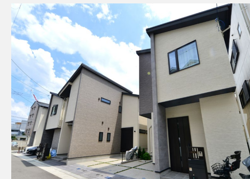
尼崎武庫之荘東PRIMES (兵庫県尼崎市)
