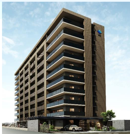
2023年5月 竣工 トラスト鳥栖本町ネクサージュ
