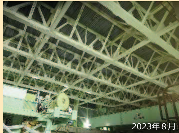
【耐震補強工事（原子炉建屋上部）】
