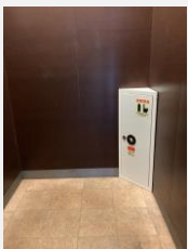
(カスティア薬院のエレベーター内 設置の非常用品収納BOX)
