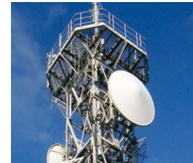
▲防災行政無線工事
