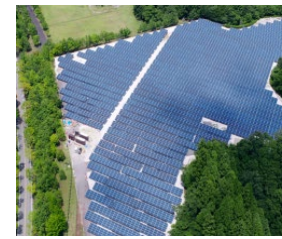
▲太陽光発電設備工事
