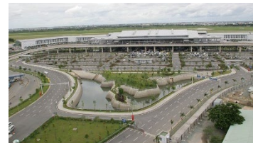
▲タンソンニャット国際空港 (電気設備工事の施工管理)
