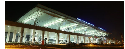
▲ノイバイ国際空港第2ターミナルビル (電気設計・施工管理・電気設備工事)
