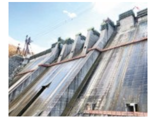
▲ハツ場ダム 電気設備・通信設備工事
