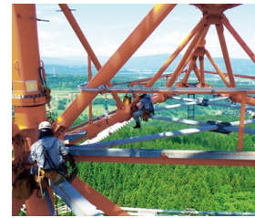
▲架空送電線設備保守業務委託工事
