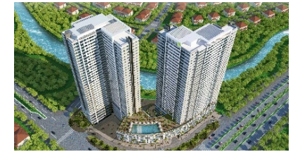
▲サンライズシティビュー (電気・空調衛生設備工事)
