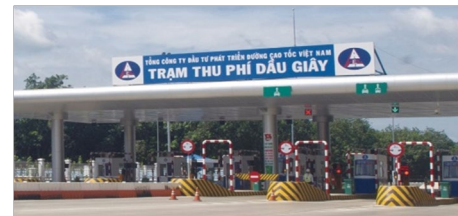
▲ベトナム 南北高速道路 ホーチミン～ソーサイ間 高速道路 (ITS工事)
