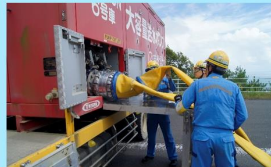
大容量送水ポンプ車による 冷却機能確保訓練
