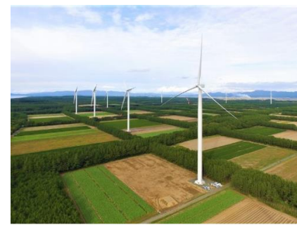
【ウインドファームつがる】 青森県つがる市 出力121,600kW (2020年4月 営業運転開始) (写真提供:株式会社グリーンパワーインベストメント)
