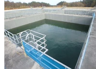
東通原子力発電所 淡水貯水槽
