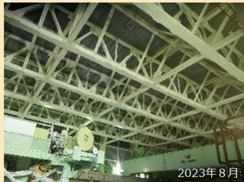
【耐震補強工事（原子炉建屋上部）】
