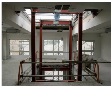
▲エレベーター新設
