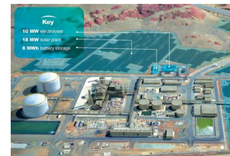
グリーン水素プロジェクト「ユリ」の完成予想図 手前がヤラ・ヒルバラ・ファーティライザー社の既存アンモニアプラント 奥が太陽光発電設備（提供：エンジー社）
